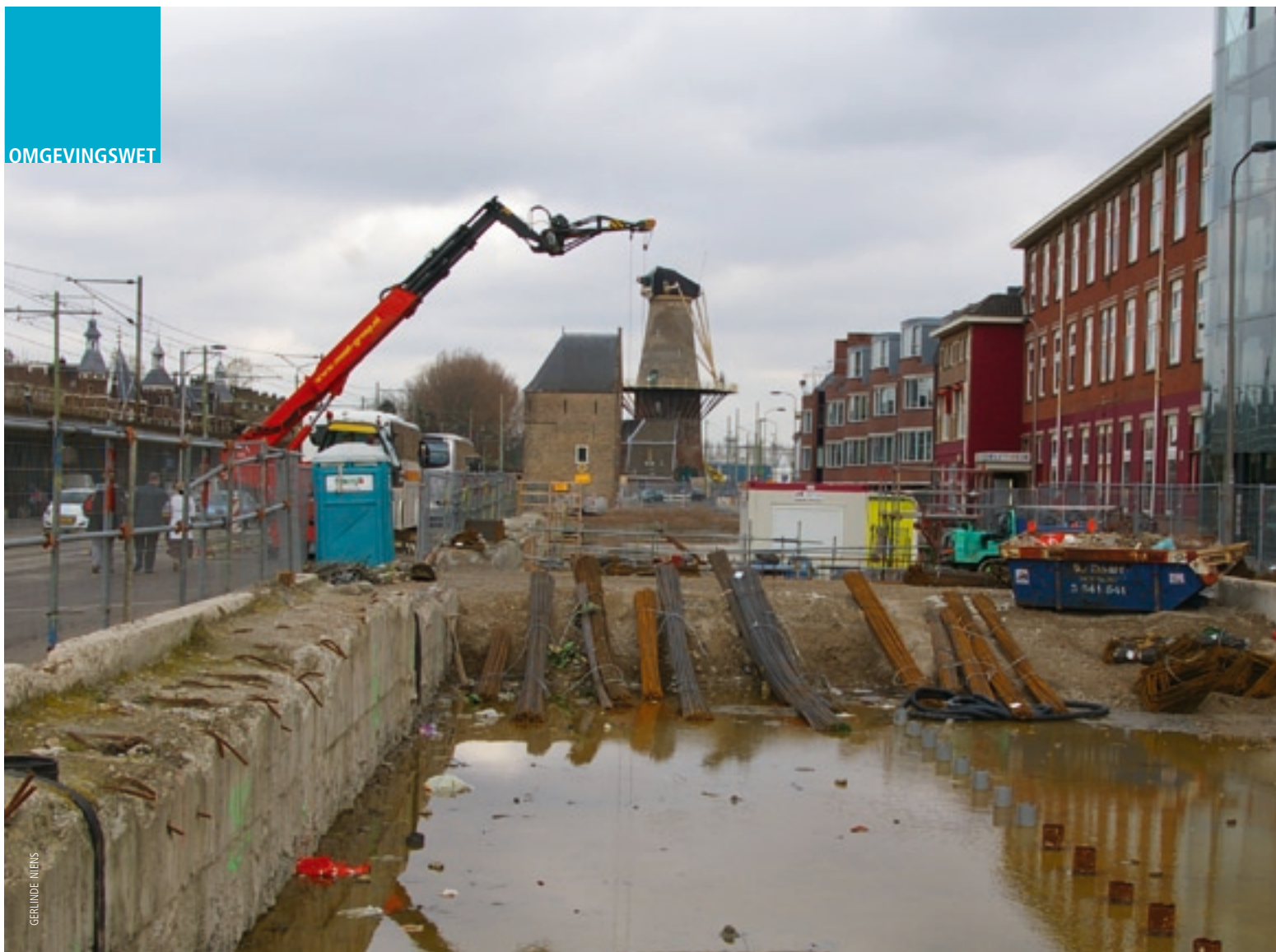
Spoorzone Delft is een complex project met een algemeen belang.
