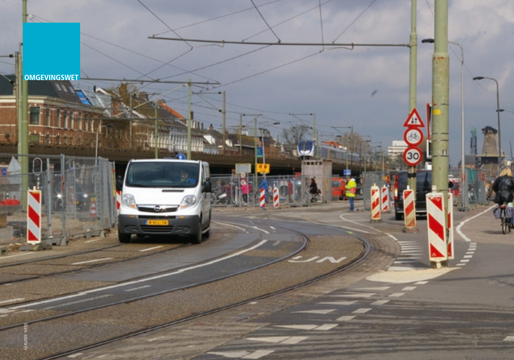
Verkeershinder tijdens de bouw van de spoortunnel in Delft.
