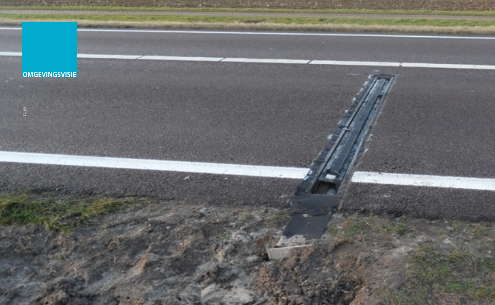
In het project N34 is een pilot ingepast om lokaal energie op te wekken uit trillingen.
