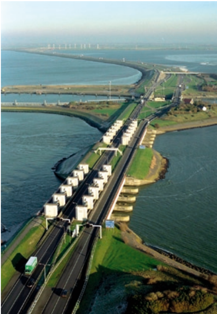
De sluis in de Afsluitdijk bij Kornwerderzand.
