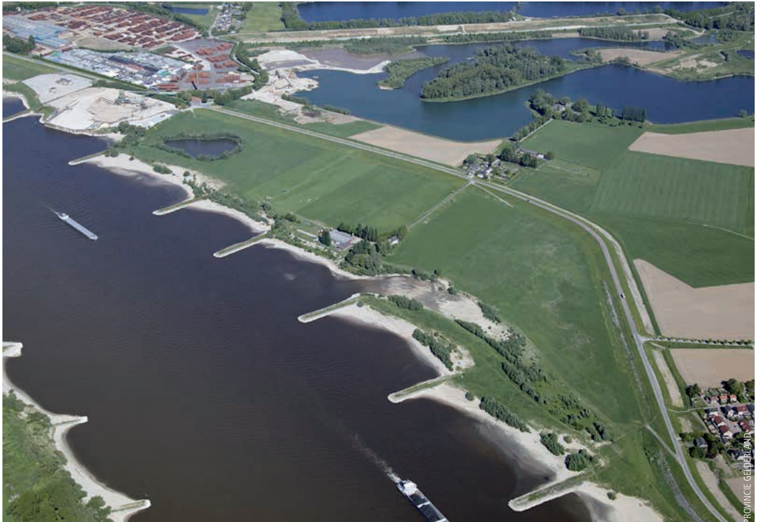
De Beijenwaard: uiterwaard waar de haven Spijk wordt gerealiseerd.
